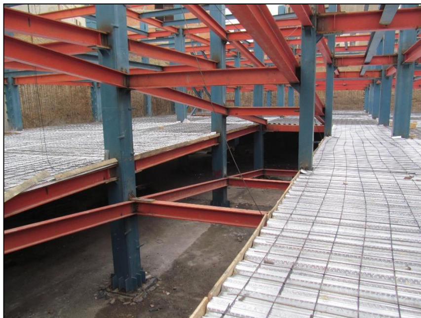
شکل ۱۲: قالب بندی لبه های سقف عرشه فولادی
