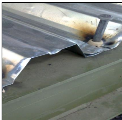
شکل ۲: نحوه اتصال ورق توسط گلمیخ به تیر فولادی
