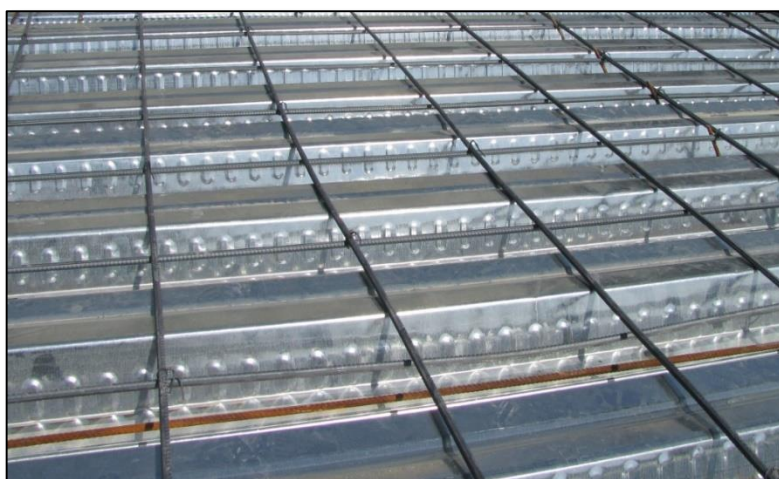
شکل ۴: آرماتور حرارتی سقف عرشه فولادی
