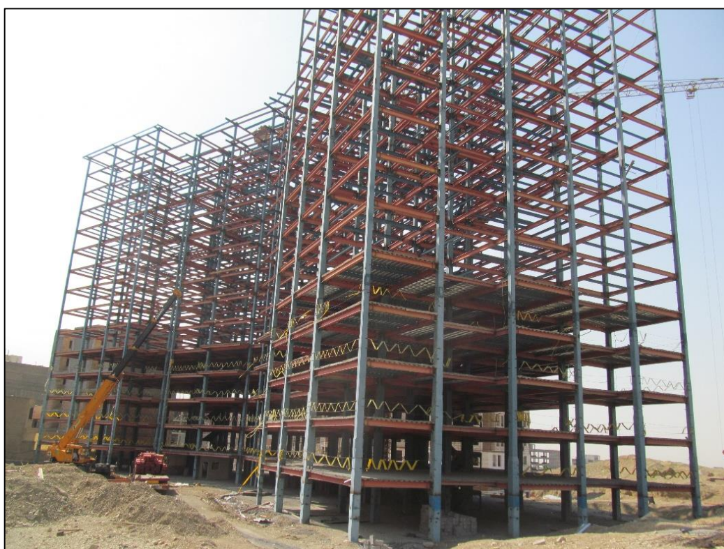
شکل ۱۱: ساختمان اسکلت فلزی با سقف از جنس عرشه فولادی
